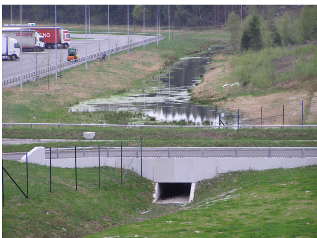
Figur 5. Et større åpent fordryningsmagasin er anlagt i et tidligere bekkeleie på tomtens laveste punkt. 75 cm skiller laveste og høyeste vannstand. Slake vegetasjonsdekkede skråninger sikrer god infiltrasjon og sedimentasjon av overflatevann fra parkeringsarealer. Foto: Eivind Saxhaug
