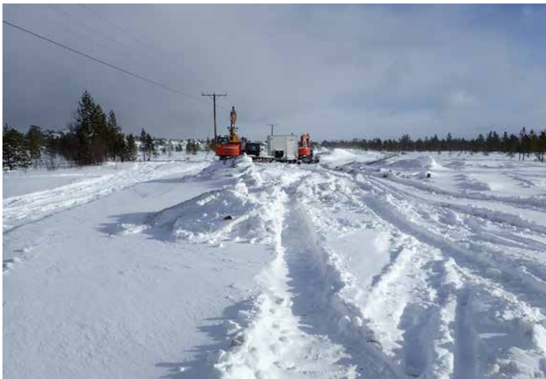
Figur 9: Anleggsarbeid på vinterføre er spesielt skånsomt for terrenget. Vær oppmerksom på å unngå at lagrete jordmasser blandes med snø slik at dette flyter utover terrenget under snøsmelting.
