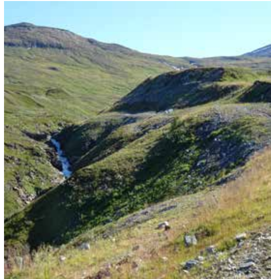
Figur 3: Revegetert og tilbakeført som kjøresterkt terreng tre år etter bygging. Skjæringer og fyllinger bakover i bildet er dempet mens bærelaget under vekstmassene er intakt.
