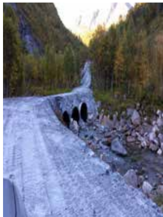
Figur 4: Krysning av bekk ved bruk av kulverter.
