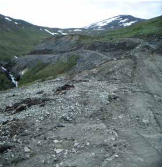
Figur 2: Bygging av Dittielva kraftverk. Midlertidig anleggsvei og rørgate opp til inntaket.
