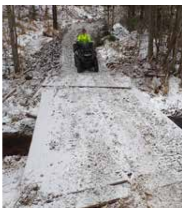
Figur 5: Kjøresterke plater til krysning av bekk.
