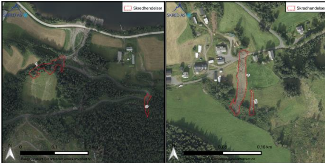
Figur 18: Skredhendelser fra ekstremværet Hans ved Skarvhaugvegen (til venstre) og ved Riste (til høyre) tegnet inn på ortofoto tatt den 21. august 2023 (Statens vegvesen et al., 2023b). På ortofoto til venstre vises også erosjon og massetransport av løsmasser langs veg.
