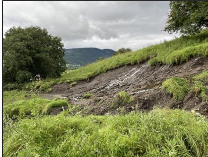
Figur 5-21: Løsneområdet for jord- og flomskredet som gikk over Skarven-vegen etter «Hans». Helningen er omtrent 20 – 25 grader.
