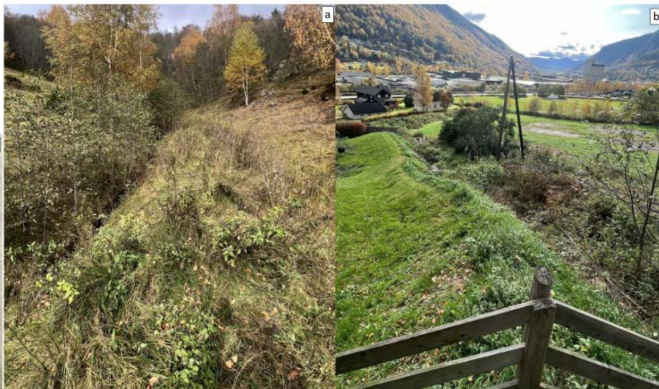
Figur 3-24. Ledevoll bygget ved huset ovenfor midtre Kleivrud, etter skredhendelsen i 2013. Bilde a er tatt oppover i fjellsiden, og bilde b viser vollen langs hagekanten av øvre huset ovenfor midtre Kleivrud.
