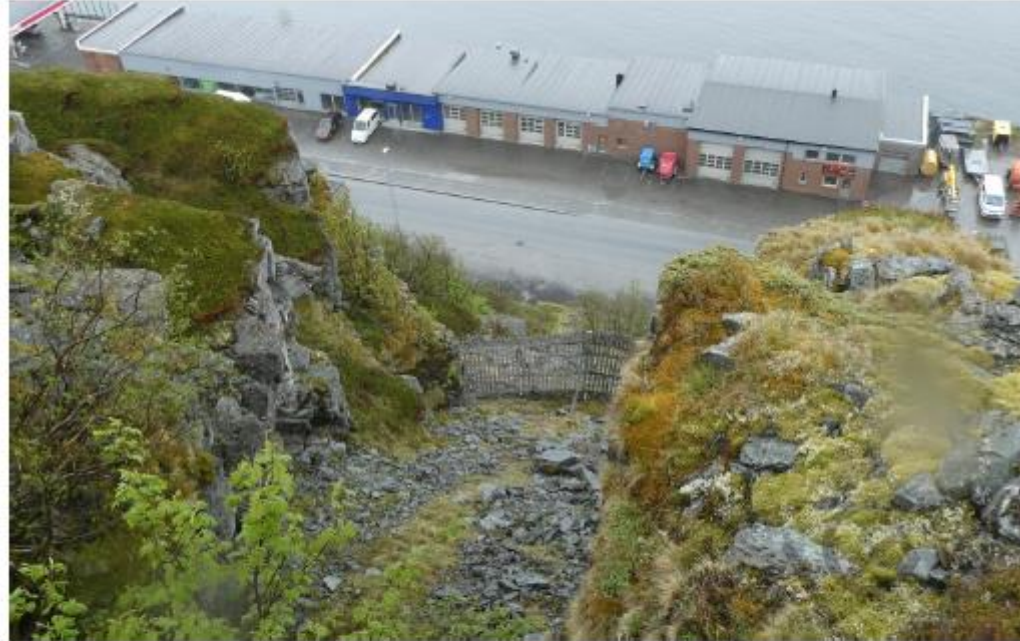
Figur 6-7 Sikringstiltak i tre ovenfor Fuglenesveien 26.
