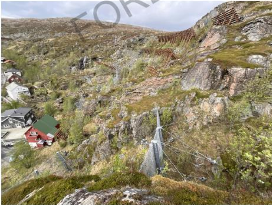
Figur 6-5 Kombinert sikring med støtteforbygninger og steinsprangnett i området ovenfor Fjellgata 29 – 41.
