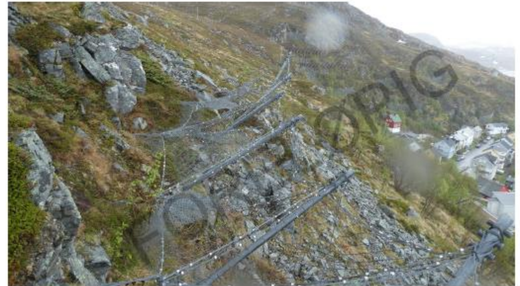
Figur 6-6 Fleksibel støtteforbygning mot snøskred ovenfor Fuglenesveien 9.
