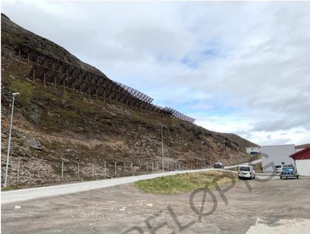
Figur 11-4 Støtteforbygninger ved Rørvikvannet.
