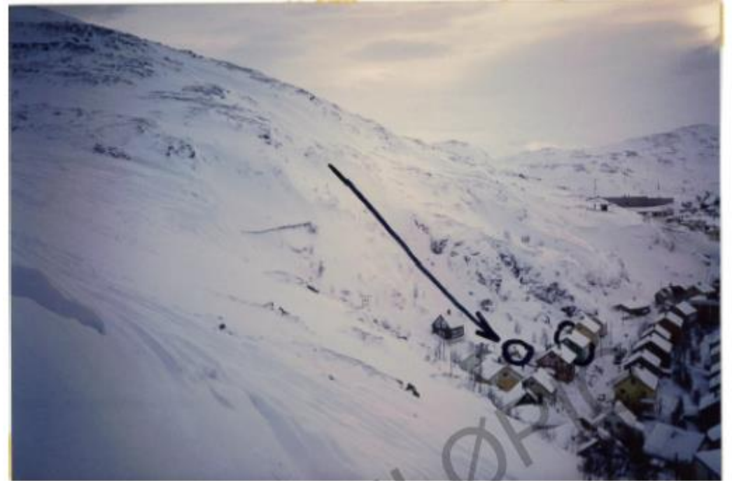
Figur 6-4 Snøskredet i Fjellgaten 1989-03-01. Pil angir skredbanen. Hus skadet av skredet er merket med ring. (NGI 894020-01).
