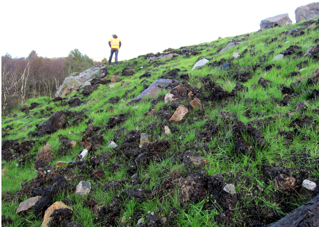
Figur 3: Fra Lista vindkraftverk. Her er det sådd for å begrense erosjon i en bratt veifylling. Steinblokker og vegetasjonsflak er lagt ut i de tilbakeførte toppmassene før tilsåing. Foto: NVE.
