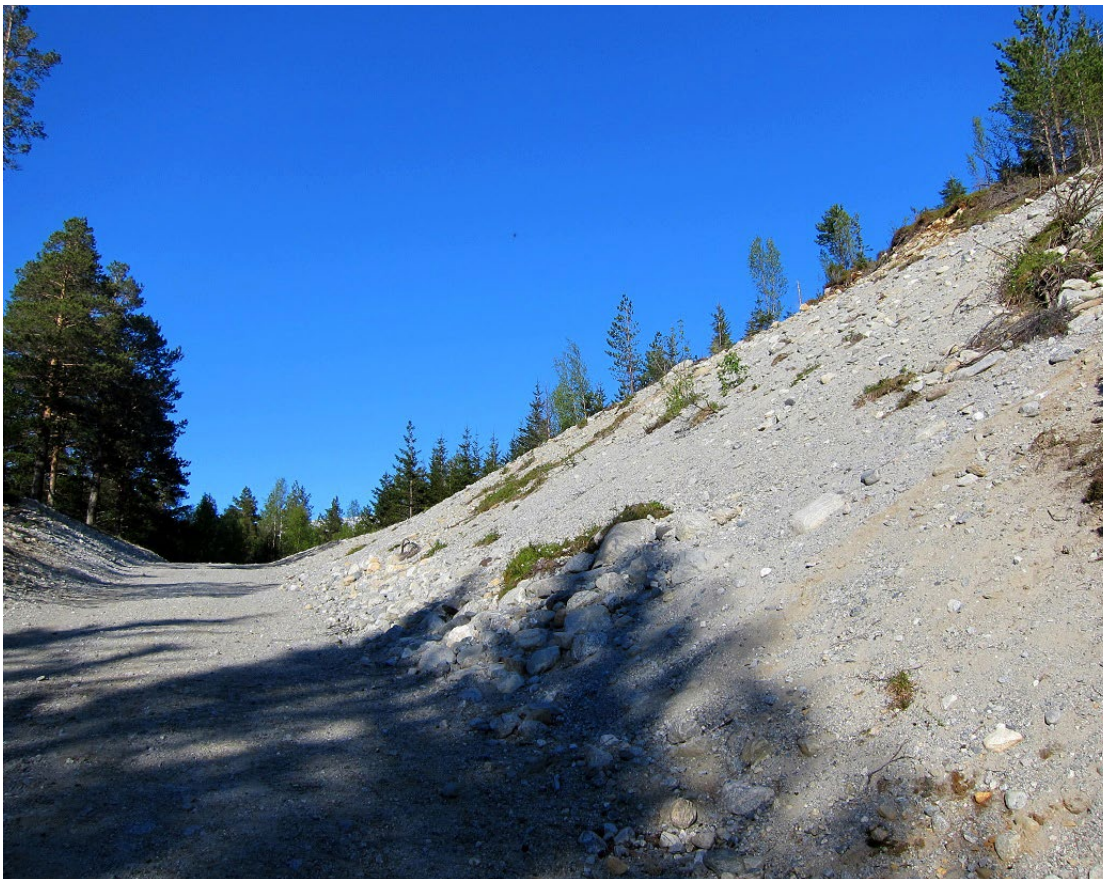
Figur 2: Eksempel på løsmasseskjæring med minimal gjenvekst flere år etter veien ble anlagt. Her bør man påføre vekstmasser og bruke geonett eller kokosmatter for å holde på massene til vegetasjonen har etablert seg. Foto: NVE.
