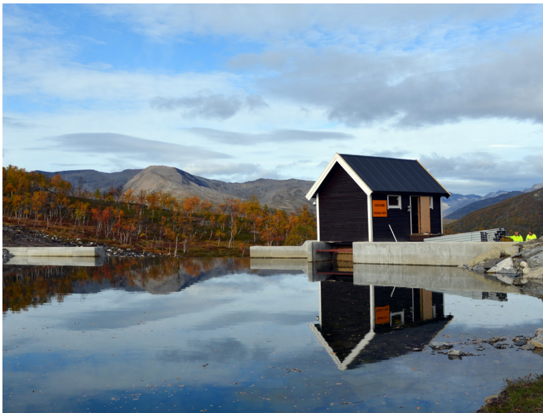
Inntak Langdalselva i Kvænangen. Foto: Kjetil Greiner Solberg.
