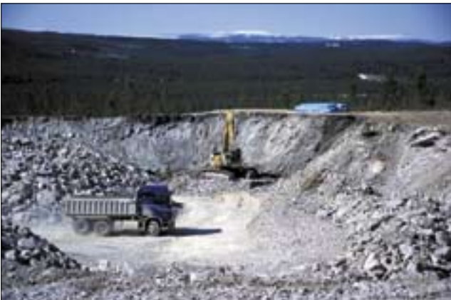
Fronten av tippen står igjen og danner en effektiv skjerm som begrenser støy og innsyn til uttaks- og produksjonsområdet. Når uttak fra tipp planlegges bør det legges vekt på å skjerme uttaket for innsyn og begrense støybelastningen mot omgivelsene. Nye Osa.
