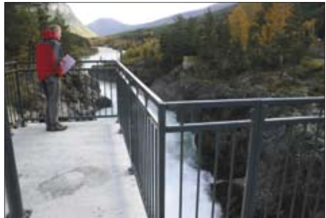
I tilknytning til dammer, overløp og luker vil det ofte være behov for sikringstiltak. Utformingen bør ta utgangspunkt i gjeldende sikkerhetskrav samt en arkitektonisk og landskapsmessig vurdering. Dam Eidefoss.
