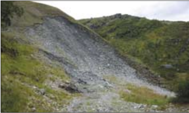
Massuttak i front av etablerte tipper skaper store erosjonssår og blir som oftest svært synlige i landskapet. Dette er en dårlig løsning. Uttak skal normalt følge uttaksplan godkjent av NVE.
