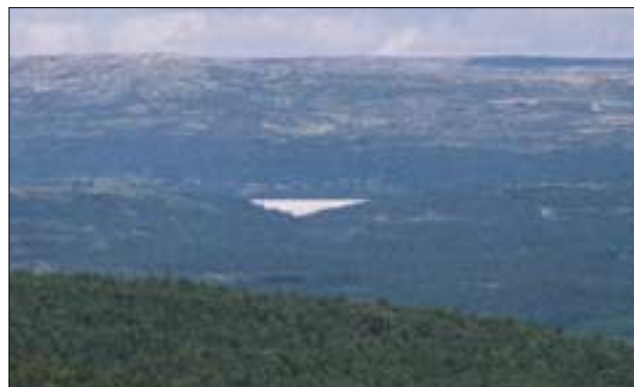
Bruk av lys steinkledning på luftside medfører at dam Falningsjø fremstår svært markert i terrenget. Foto: Tore Olav Sandnæs/NVE
