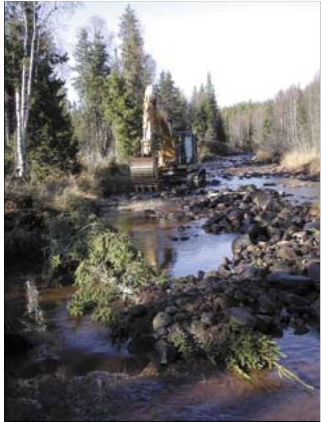
Djupål bør slynges i elveleiet og gjerne gå langs kantene der det er mer næring og skjul. I kulpene nærmest er det lagt ut trevegetasjon for å gi bedre skjul og skygge. Høljavassdraget.
