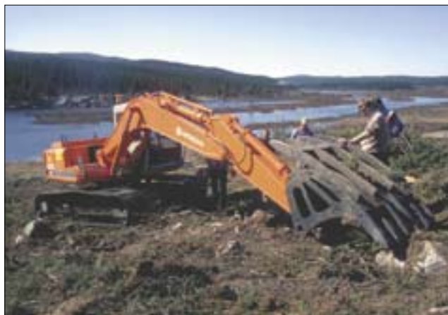
Ved etablering av Dokkfløymagasinet ble vegetasjonsryddingen foretatt med grovt spesialutstyr. Foto: Ivar M. Sæveraas/NVE
