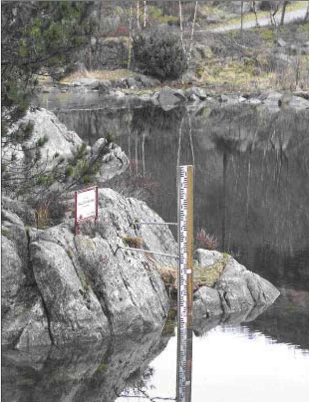
Målestav plassert beskyttet i et U-jern som beskytter målestaven for påkjenninger fra is og frost.
