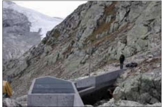
Bekkeinntak med fargetilslag i betongen. Den grå fargen er godt tilpasset omgivelsene. Sandlyfti. Foto: Trine H. Elgersma/Statkraft
