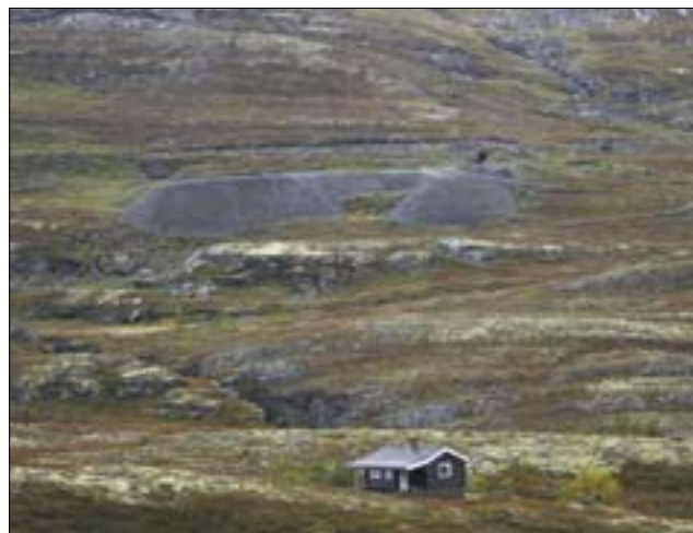
Mange eldre tipper ligger svært synlig til i høyfjellsterreg. Det må i hvert enkelt tilfelle vurderes om det er tiltak som ut fra økonomi og effekt er aktuelle å gjennomføre. Tyin.
