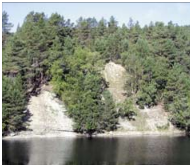
Reguleringssonen i magasinene kan være utsatt for erosjon. Enkelte steder forplanter denne erosjonen seg over HRV og skaper erosjonssår i terrenget langs magasinet. Avhengig av beliggenhet og omfang er det aktuelt å gå inn med tiltak for å stoppe/begrense erosjonen. Olstappen, Vinstra.
