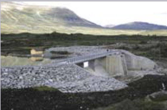
Vinsterdammen før og etter ombygging (2002-04). I den nye dammen er lukehuset plassert i lukepilar og dammen fremstår til tross for at den er blitt både høyere og bredere som mer harmonisk og landskapstilpasset.
