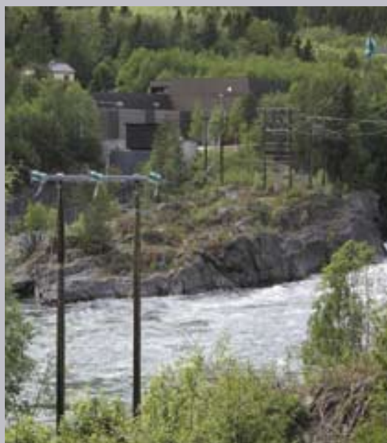
Kraftstasjonsbygg uten spesielle arkitektoniske kvaliteter kan godt dempes i landskapsbildet ved bruk av mørke farger. Gausvik (øverst) og Eidefoss kraftverk (nederst).
