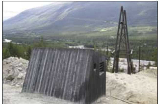
Kombinert kabelsjakthus og rømningsvei for Øyberget kraftverk, Øvre Otta. Bildet er tatt noen uker etter støping med farget betong (20 kg Ferroxon 612 per m 3 /betong) og sideterreng er ikke ferdig formet. Bordforskaling med over- og underligger gir struktur til betongoverflatene. Regn og sol har allerede gitt den svarte betongen et gråspettet preg. Planen er at konstruksjonen på sikt skal se ut som en stor grå stein oppe i lia.
