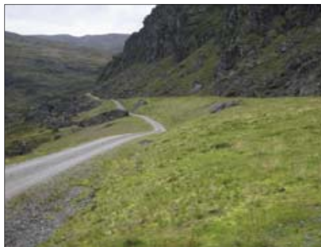
Denne eldre tippen i høyfjellet har en uregelmessig og flat form som gjør at den passer inn i landskapet og er lett å holde vegetasjonskledd. Evanger. Tipp Beinhelleren.
