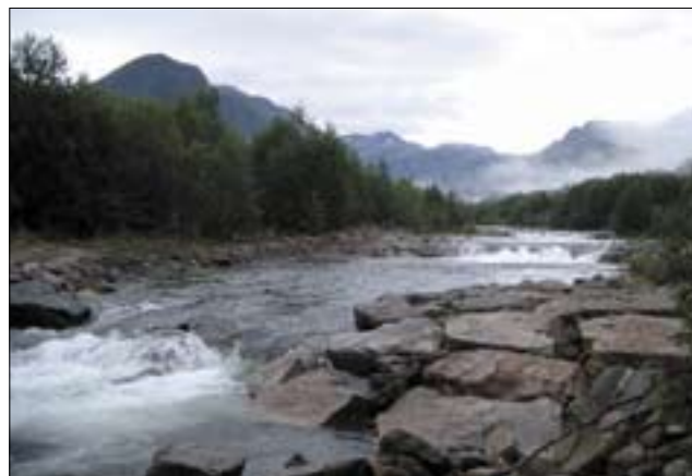
En syvdeterskel graver ut en stor høl rett nedstrøms terskelen. Glutra, Isfjorden Foto: Trine H. Elgersma/Statkraft
