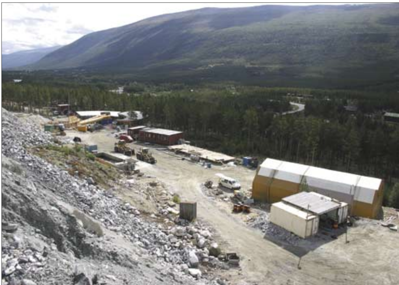
Å legge lager- eller verkstedsrigg som en del av massedeponiet (tipp) kan være en god løsning. Når anlegget avsluttes fylles tippmasser over riggområdet som blir en del av tippen. Øyberget, Øvre Otta
