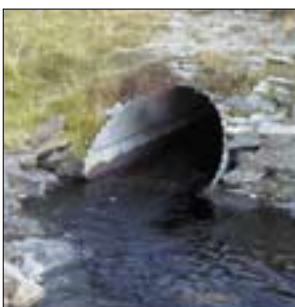
Før og etter utbedring rundt en kulvert som fungerte som vandringshinder for fisk. I dette tilfellet er vannspeilet nedstrøms kulverten hevet ved at det er bygget tre små terskler med fiskerene. Alternativt kunne en senket kulverten. Foto: Knut A. Hoseth/NVE (øverst) Foto nederst: Geir Johansen
