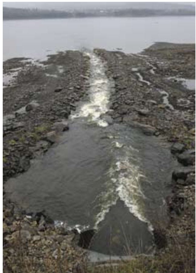
Etablering av djupål og vandringsmulighet for vårgytende harr. Før tiltaket gikk bekken i ei brei vifte gjennom reguleringssonen og oppvandringsmulighetene var dårlige. Djupålen er bygd opp som ei steinsatt renne med innlagte store steiner. Mjøsa ved Stensengbekken.
