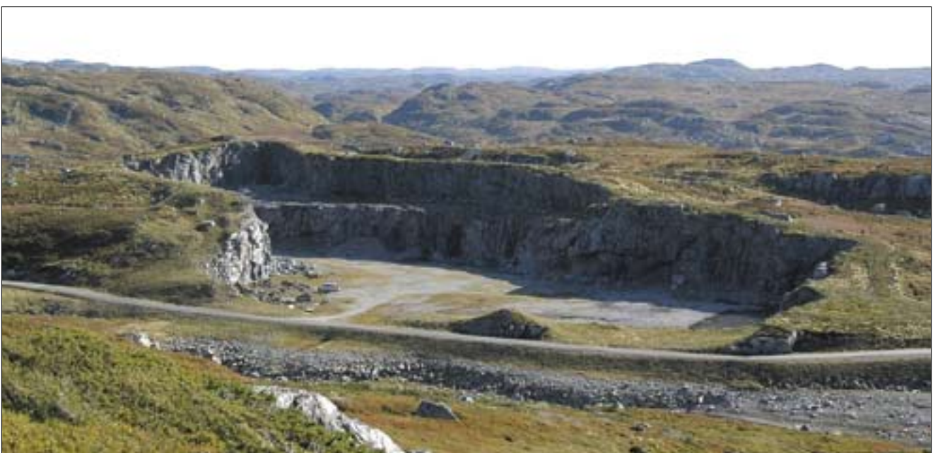
Mange store damanlegg ligger i åpent fjellandskap. Dette stiller store krav til landskapstilpasning både for dammen og ikke minst for massetakene. Steinbruddet på bildet er ikke utformet etter dagens krav, men vil i løpet av kort tid få en bedre landskapstilpasning i forbindelse med nye uttak i bruddet. Roskrepp. Foto: Einar Berg, Inter Pares as
