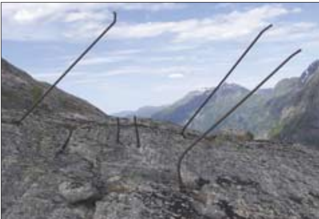
Farlige forhold som for eksempel jernbolter eller armeringsjern skal fjernes eller sikres. Foto: Oddvar Olavsén/Statkraft
