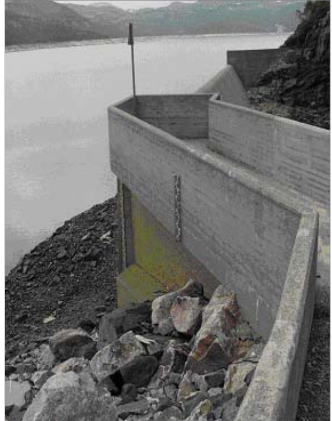
Todeling av målestav kan være en løsning der det er praktisk vanskelig å få montert en stav som dekker kravet til målehøyde.
