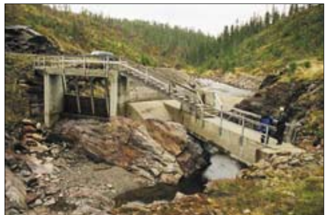
Ved planlegging av bekkeinntak bør det legges vekt på å unngå "kråkeslott" som dette Foto: Tore Sandnæs
