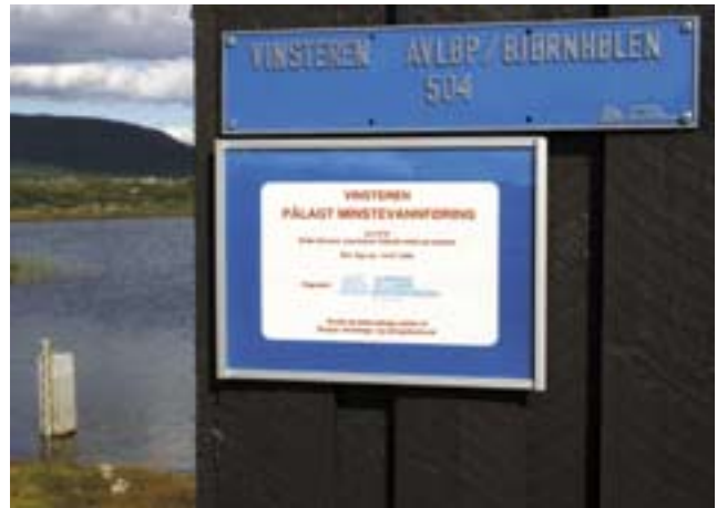
På steder hvor det er gitt pålegg om minstevannføring, skal det settes opp skala/målestav. I tillegg skal det settes opp opplysningsskilt som er lett tilgjengelig og synlig for allmennheten.
