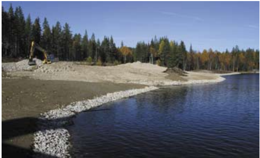
Deler av overskuddsmassene fra utspredning av ny kraftstasjon er lagt i ei bakevje og formet som et nytt terreng med flere høydedrag. Sprengsteinsmassene er dekket med morene og vekstmasser. I strandsonen er det tilført et belte med elvegrus/elvestein. Sagnfossen.
