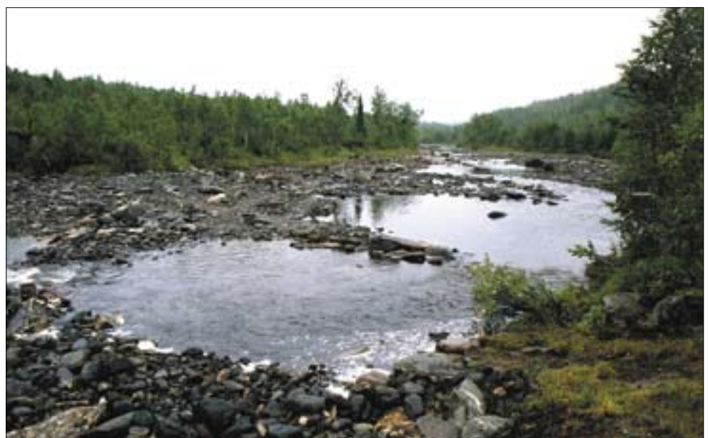
Et bredt og grunt elveløp med redusert vannføring er korrigert slik at vannstrømmen og vannflatene blir bedre definert. Dette gir økt fysisk variasjon og bedrer overlevingsmulighetene for fisk i lavvannsperioder sommer og vinter. Gluggvasselva. Foto: Tore Olav Sandnæs/NVE
