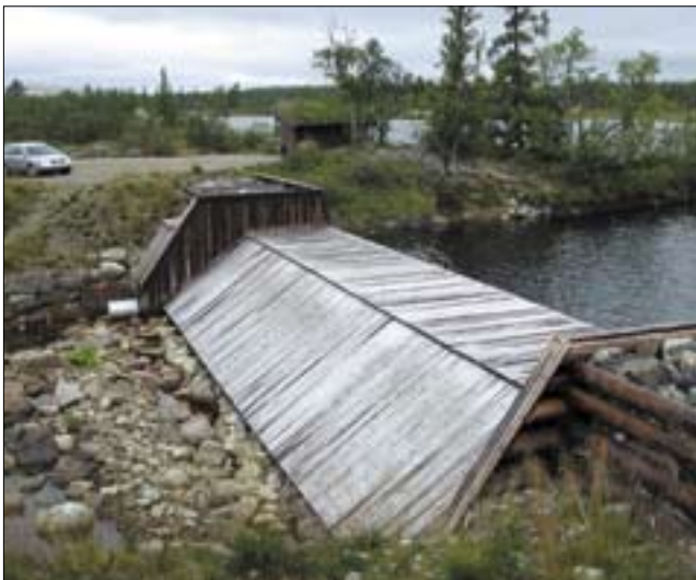
Ved mindre, eldre dammer med kulturhistorisk verdi eller tradisjonsverdi kan bruk av byggeteknikker som f. eks tømmerkister gi et godt resultat. Dam Hyllsjøen, Hylla
