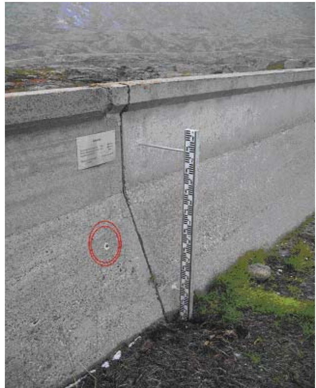
Felles HRV/LRV-skilt, skala og HRV-bolt festet på dam.
