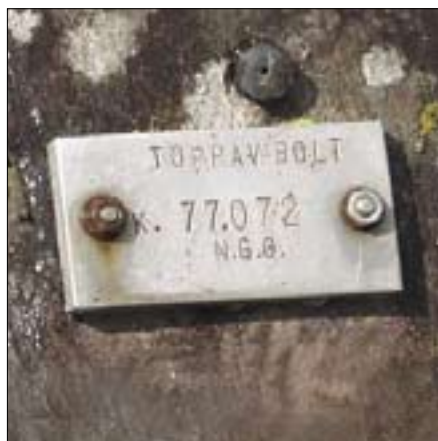
Fastmerkebolt med opplysning om høyde
