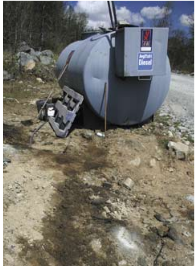
Påfylling av drivstoff skal skje slik at spill som dette unngås. Bruk påfyllingsutstyr som ikke gir spill og ordne påfyllingsplassen slik at eventuelt spill kan samles opp.
