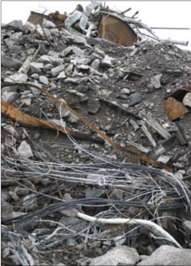
Ved masseuttak fra eldre steintipper, dukker det ofte opp store mengder avfall som er deponert i tippen. Dette må behandles på forsvarlig måte. Tipp Nye Osa kraftverk.
