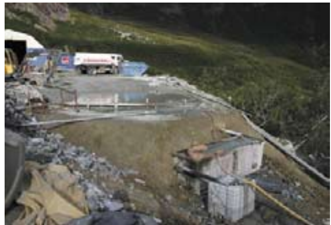
Ved tunneldrift og annet fjellarbeid blir det mye slam- og nitrogenholdig avløpsvann. Fylkesmannen krever normalt rensing av dette i flertrinns sedimentasjonsbasseng samt infiltrering i grunnen som her ved tverslag Raudalen, Øvre Otta
