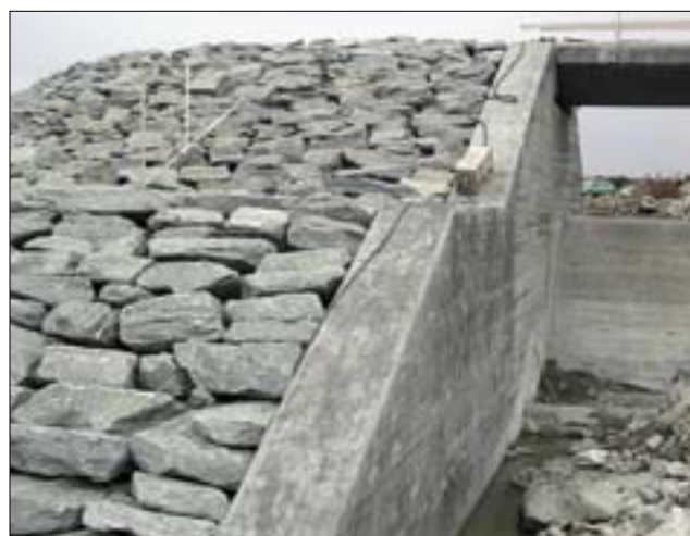
Den håndverksmessige utførelsen av støpearbeider, plastringsarbeider og tilslutninger til sideterreng har stor betydning for sluttresultatet. Dam Vinstern under bygging.
