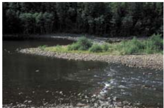
Bassengterskel anlagt med buform og tilknyttet ei øy i vassdraget. Denne utformingen fungerer svært godt for å få terskelen til å gli inn i elvemiljøet. Neavassdraget
