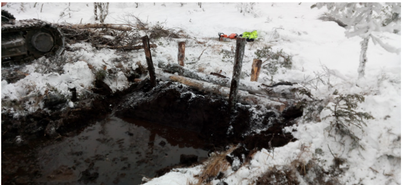
For å forsterke pluggen legges det stokker i den.
