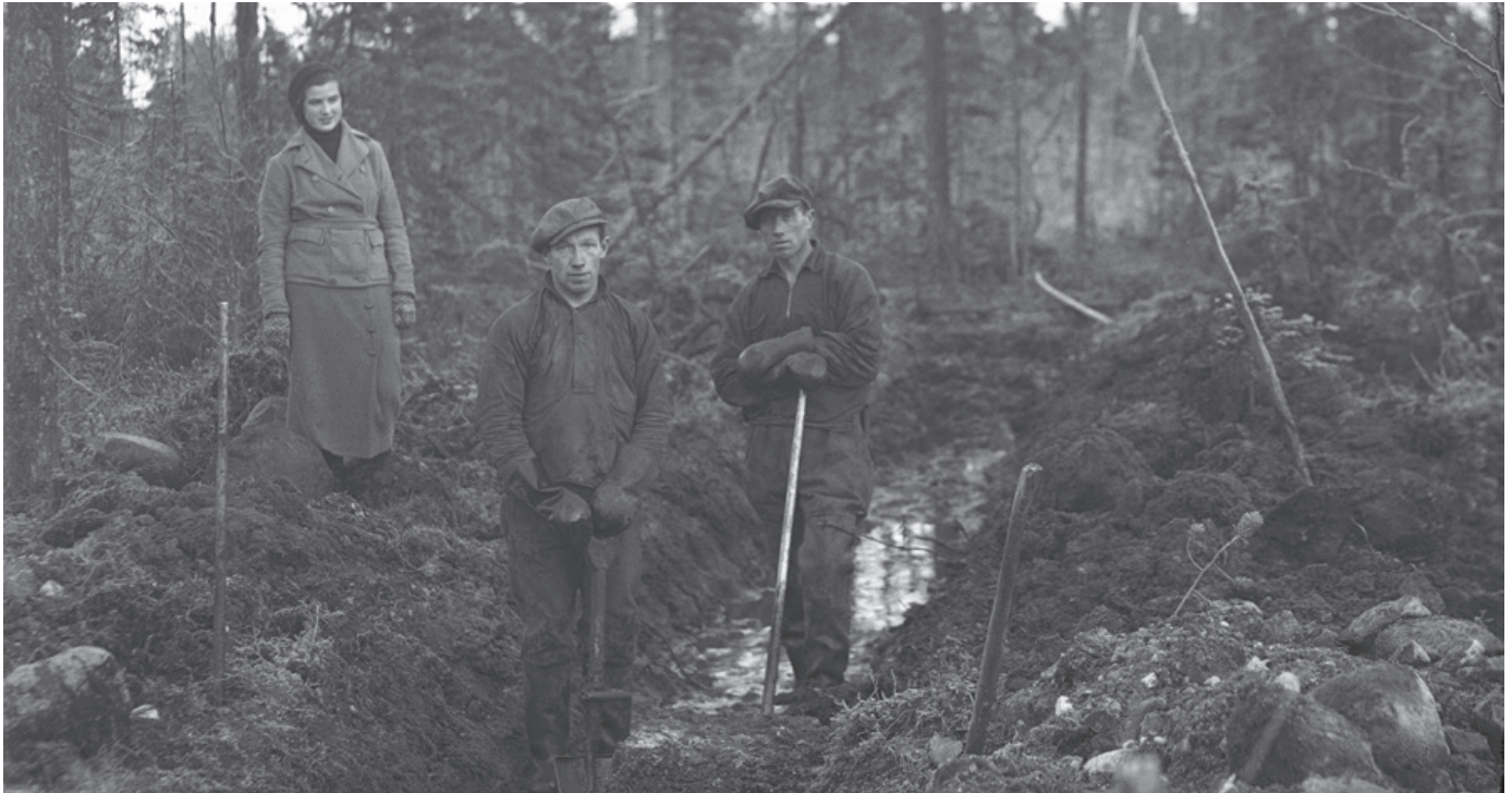
Mye av dreneringen er gjort for hånd, og det er ikke få arbeidstimer som er lagt ned på å grave grøfter. Foto: Norrbottens museum
