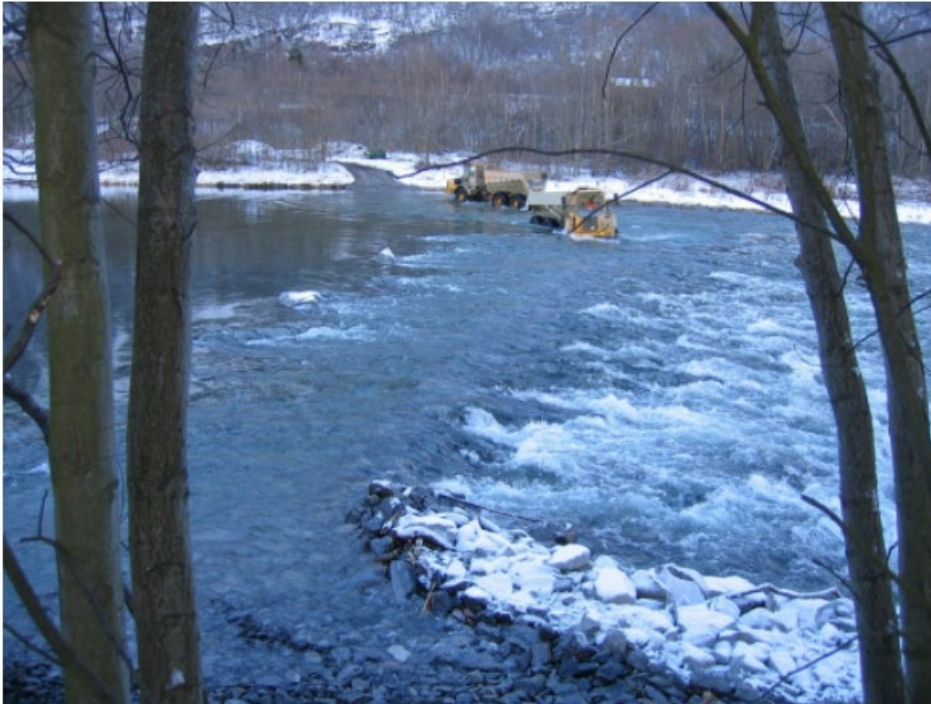
Figur 11: Anleggsvei med dumpere som krysser et Driva, Sunndal kommune. Foto: Mads Johnsen, NVE
