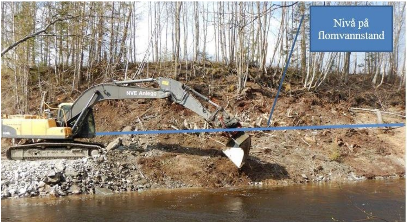
Figur 9: Vannstand på bilde ved ca. middelvannføring ved ferdig legging, Nivå på flomvannstand er tegnet inn og ligger høyere enn anleggsveien. (Foto: Geir B. Hagen, NVE).
