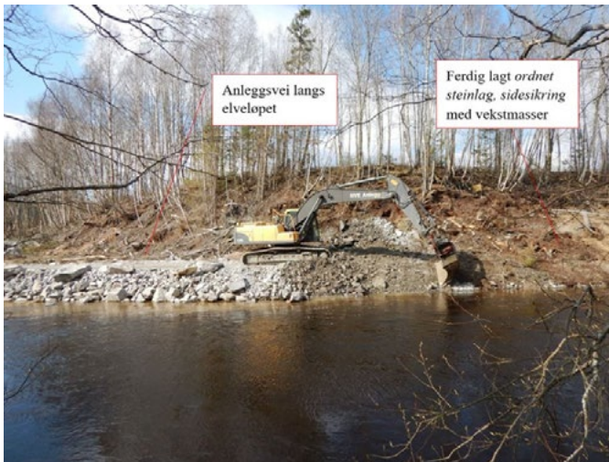
Figur 4 : Gravemaskin holder på med sluttarbeidet.
