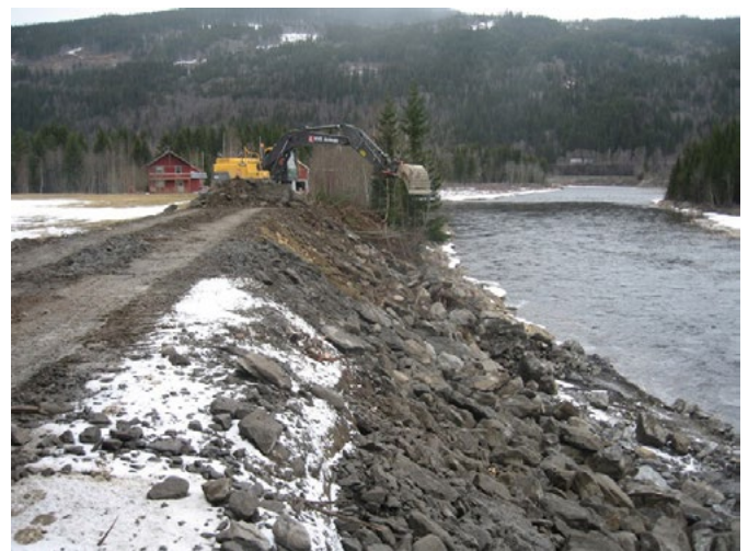
Figur 7: Eksempel på bygging av ordna steinlag, sidesikring i slak elveskråning med liten vanddybde ved Kirkvolløy, Midtre Gauldal kommune (Foto: Joar Skauge, NVE)
