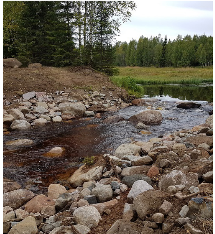
Etter utbedring. Vi har laget et stryk for å opprettholde vannstanden på innsjøen ovenfor dammen.
