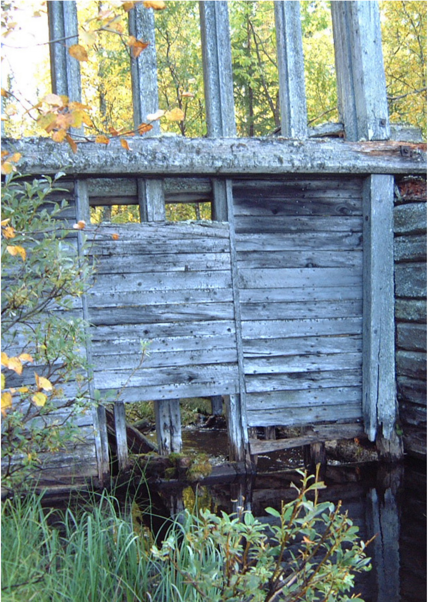
Fløtningsdam med luker og tømret overløp.
