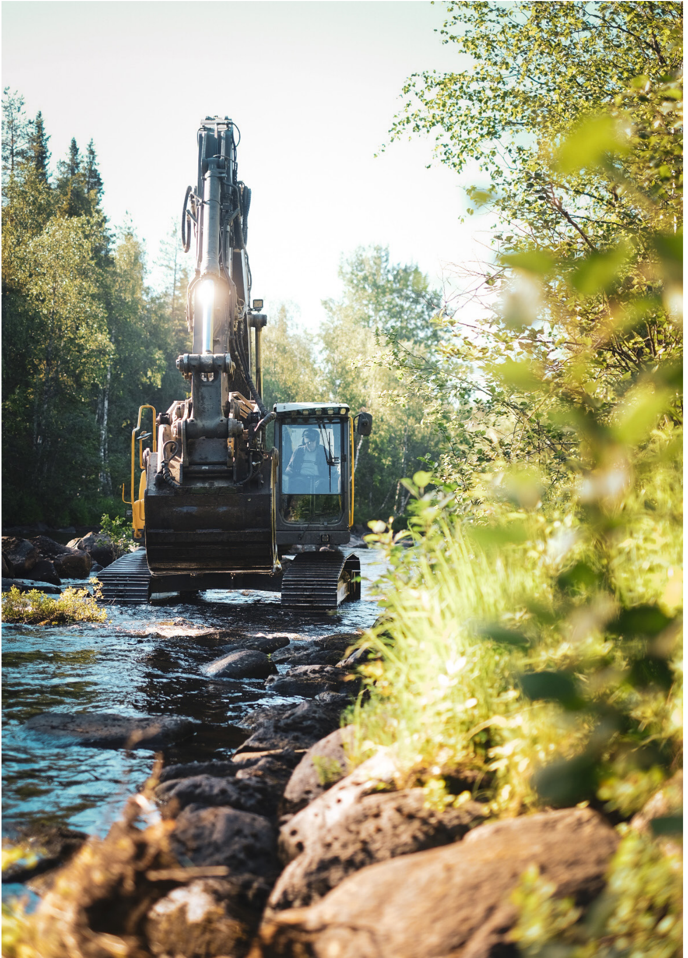
Miljørestaurering av elver og bekker utføres ofte med gravemaskin. Foto: Jeremias Kinnunen-Levy
