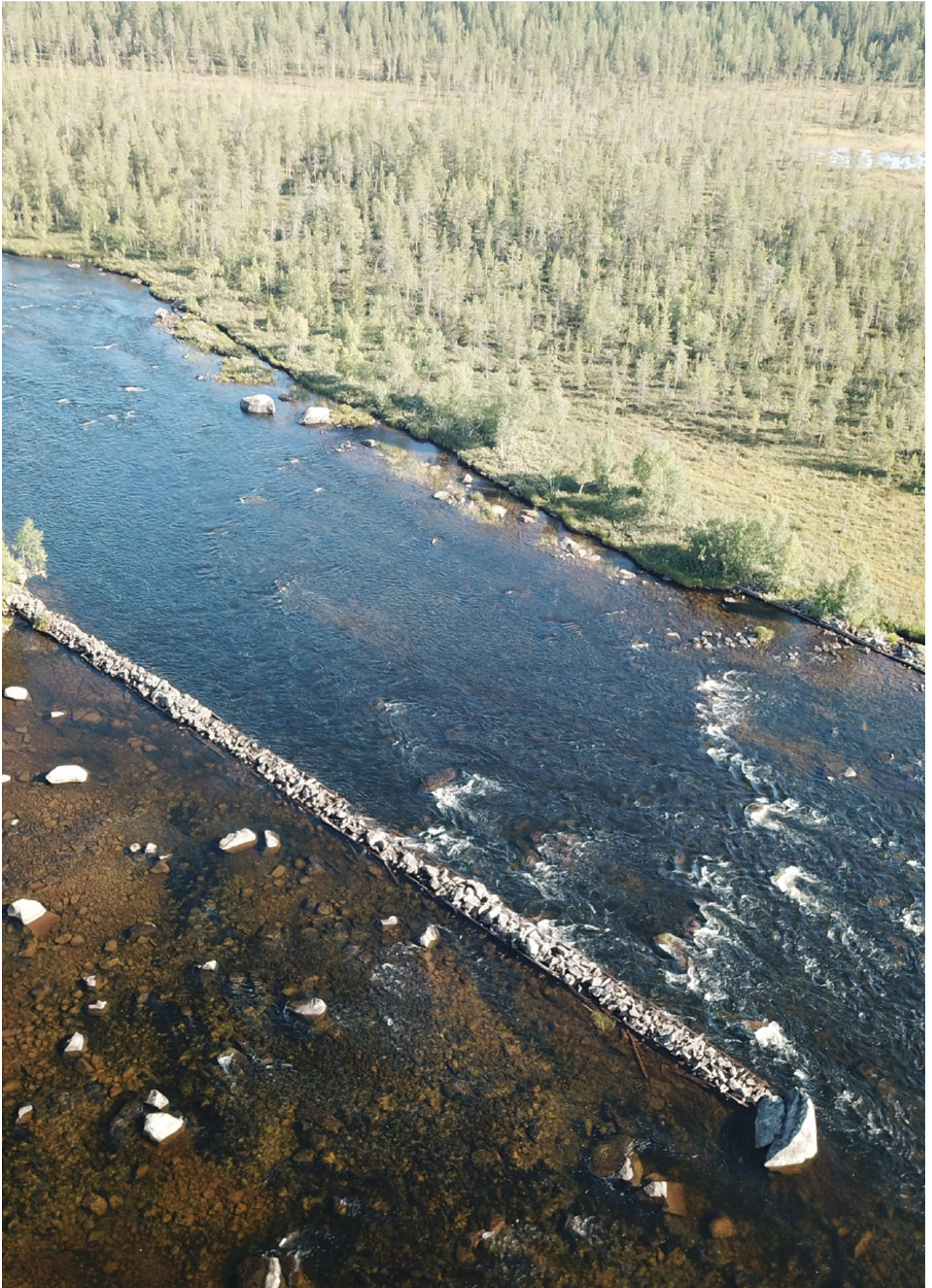
Store ledevollen ble bygget opp i og langs vannløpene for å hindre at tømmeret satte seg fast i bredden. Flyfoto fra Pärlälven i Jokkmokk kommune.
