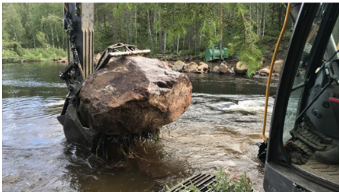
Under restaureringsarbeidet flyttes store steiner ut i vannet igjen. Da trengs det gravemaskin.
