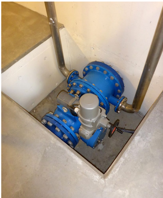
To ulike eksempler på omløpsventiler i kraftverk. Foto: Lars Midttun, NVE.
