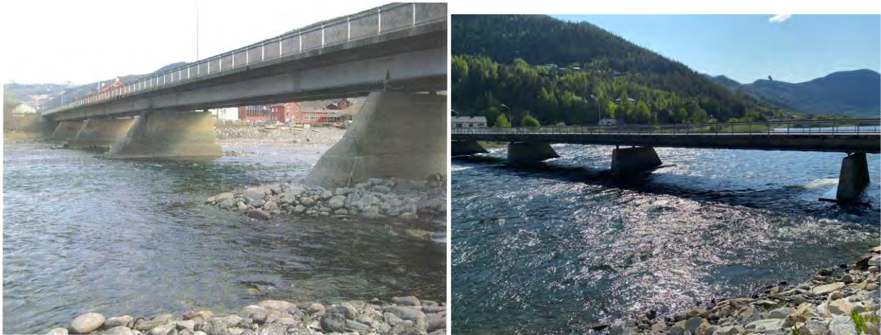
Bilde på oppstrøms side av bru. Pilar II nærmest, og videre pilarene III til V.
