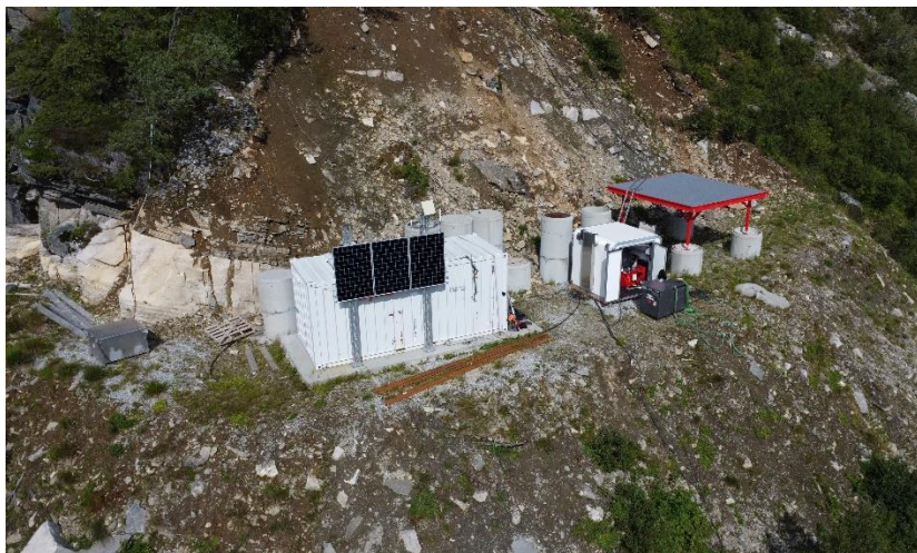
Figur 2-7: Borehullskontainer, strømforsyningsbrakke og helipad (KH-02-17 på Åknes).
