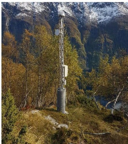
Figur 2-6: Mast med GPS og prisme.
