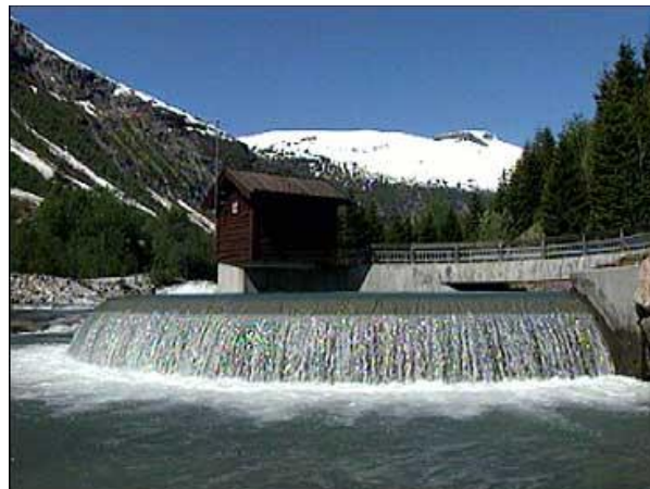
Utløpet frå Mel kraftverk i Vetlefjorden. (Foto: Tor Sivertstøl, NRK)
