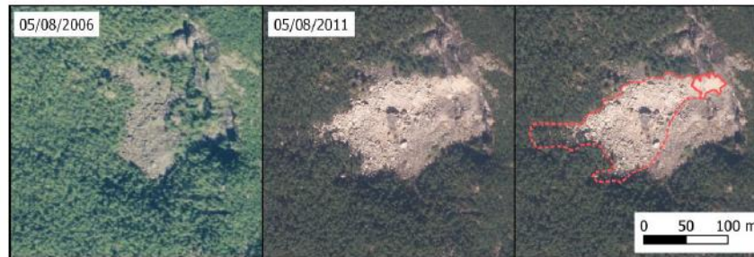
Figur 39: Skredet gikk mellom 2006 og 2011. Ut ifra flateareal av kildeområde (660 m 2 ) og høydeforskjell (ca. 50 m) kan volumet anslås mellom 5.000 og 15.000 m 3 . Sør for kildeområde ble vegetasjonen fjernet, men det virker ikke relatert til selvet skred. SLBL gir ca. 9000 m 3 for avsetningen, men det er ikke veldig nøyte da den tar med noen blotninger i volumberegning
