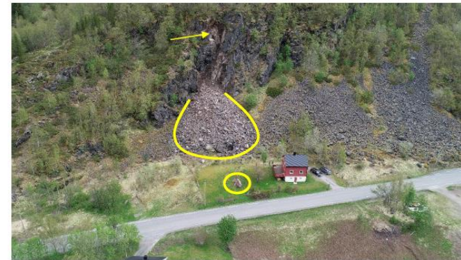
Figur 44: Stein som kom ned ved siden av huset på Spansdalsveien 447 den 22 mai 2023 (hendelse 11 i Figur 38 og i Tabell 11). Bildet er tatt på feltbefaring den 2 juli 2023. Pilen viser løseområdet, mens sirkelen viser blokken. Det kom ned mye materiale i form av mindre blokker samtidig, noe som gi en hvit utsende til steinura.
