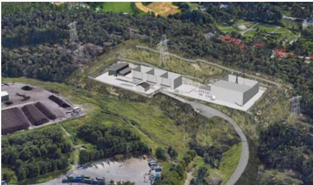
Flymontasje/3D-modell av innendørs transformatorstasjon.
