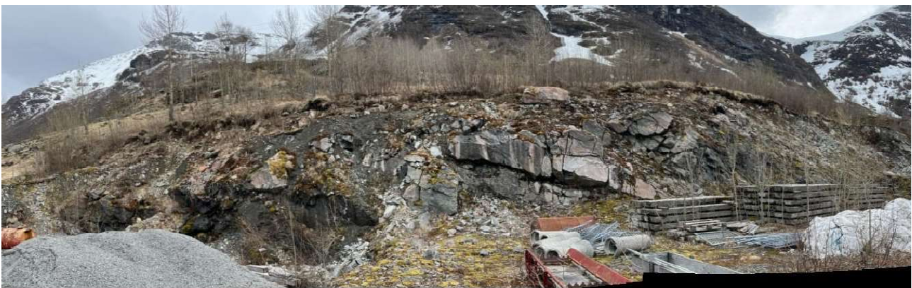
Figur 6-18: Bilde viser bergskjæring ved lagringsarealet sør for gården og mulig angrepspunkt for forskjæring. Fotoretning mot øst.
